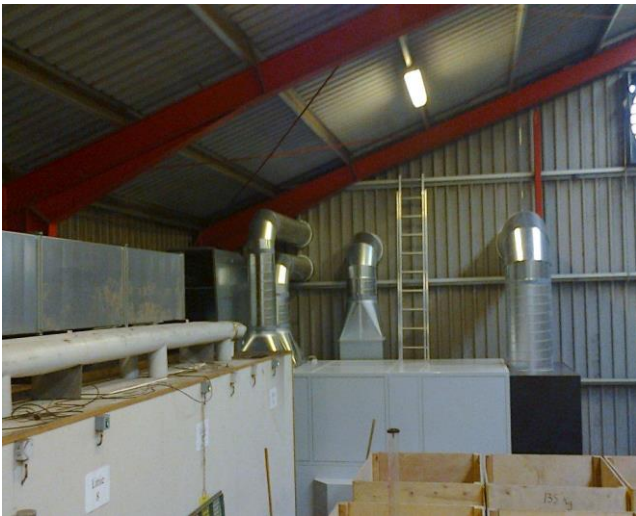
Le déshumidificateur central est connecté au canal d'air.
