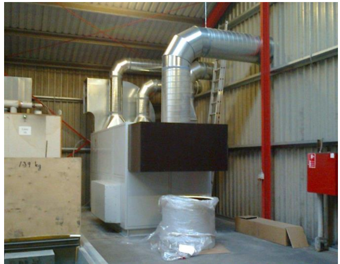
Le déshumidificateur d'air par absorption.
