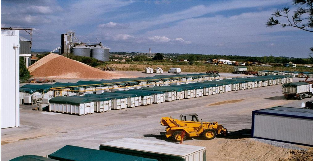
Aperçu des installations de séchage en conteneurs
