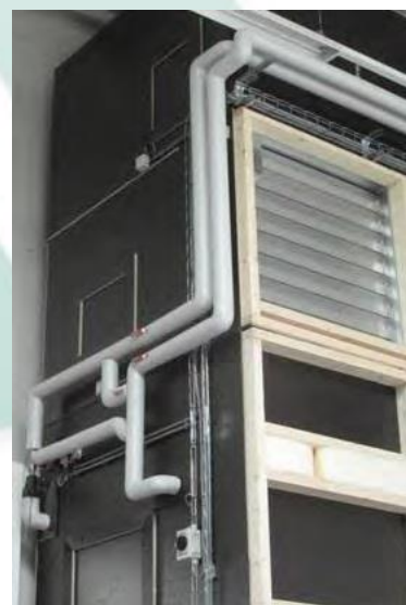
Connexion des tuyaux vers la batterie d'eau dans le caisson de répartition d'air.
