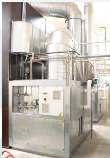
Séchoir par absorption
